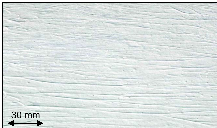
Bild 8.2: Porenbetonoberfläche nach einer mechanischen Reinigung mit einer Handreinigungsbürste unter fließendem Wasser.
