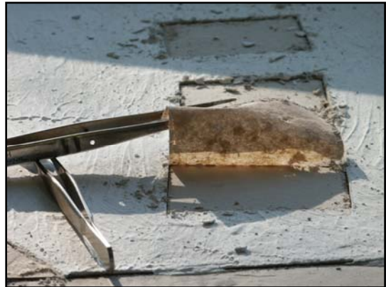
Bild 5.2: Entnahme einer Schicht des Zellulosebelags einer GK-Platte.
